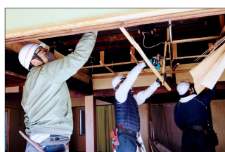
(解体中の様子)
